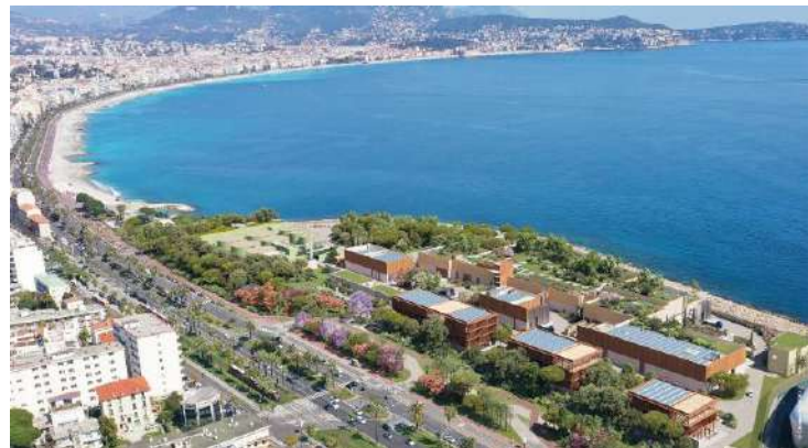
Figure 126 : Vue du bâtiment tertiaire qui accueillera les services techniques de Eau d'Azur et l'ODD (hors projet)
