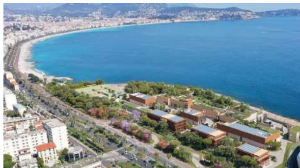
Figure n°12. VUE DU BATIMENT TERTIAIRE QUI ACCUEILLERA LES SERVICES TECHNIQUES DE EAU D'AZUR ET L'ODD (HORS PROJET)
